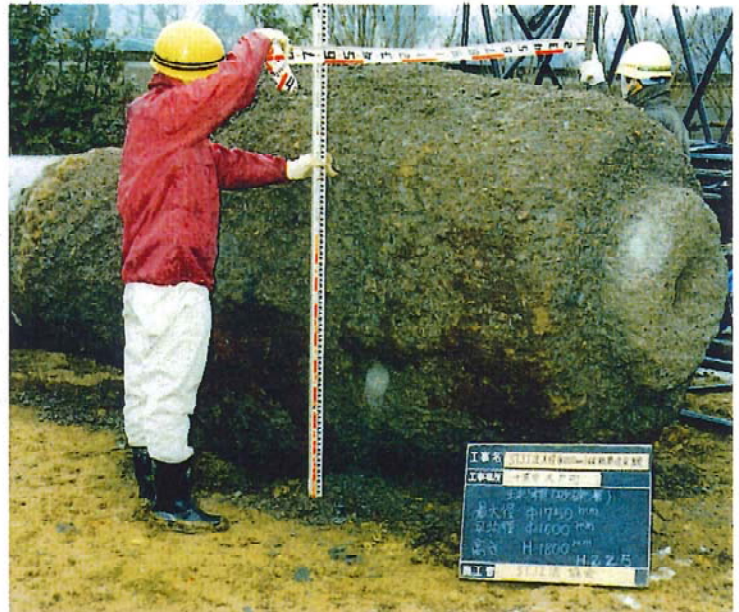
▼杭径1,000mmの球根築造掘出し状況
